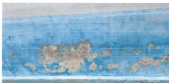
Foto 3: PINTURA EN MUROS INTERIOR Y EXTERIOR
